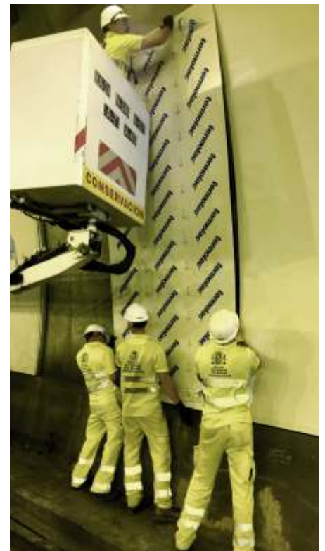
Forrado de tuneles
